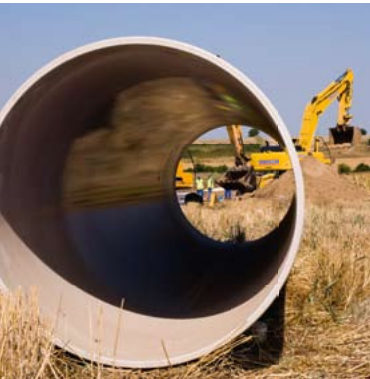
Po ugradnji, novi sustav cijevi vodovoda će poboljšati snabdijevanje čistom vodom.
